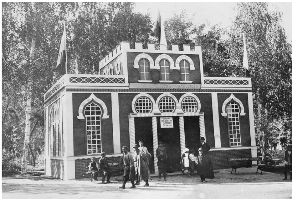
Рисунок 4 – Павильон торгового дома Г.А. Шахворостова с сыновьями и Ф.А. Пестова, выполненный в мавританском стиле [8]
